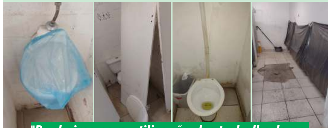
"Banheiros para utilização dos trabalhadores ao lado do refeitório no Distrito"
